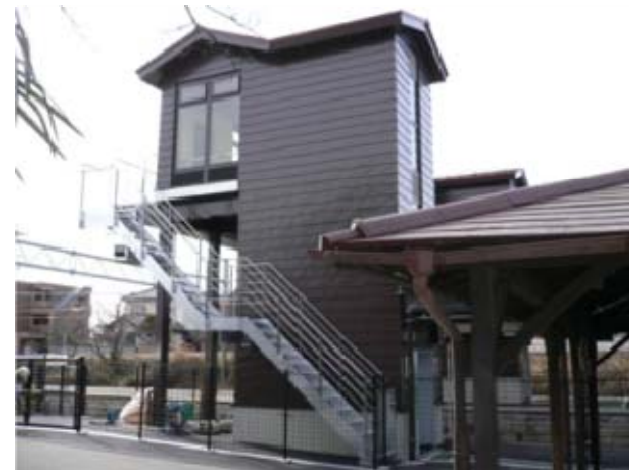
駅におけるエレベーターの設置（亀崎駅）
