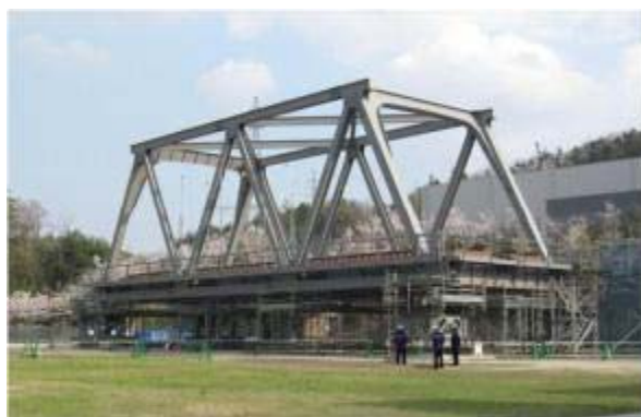
試験トラス橋
