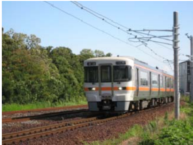
武豊線電化工事
